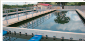
建設した水道設備
