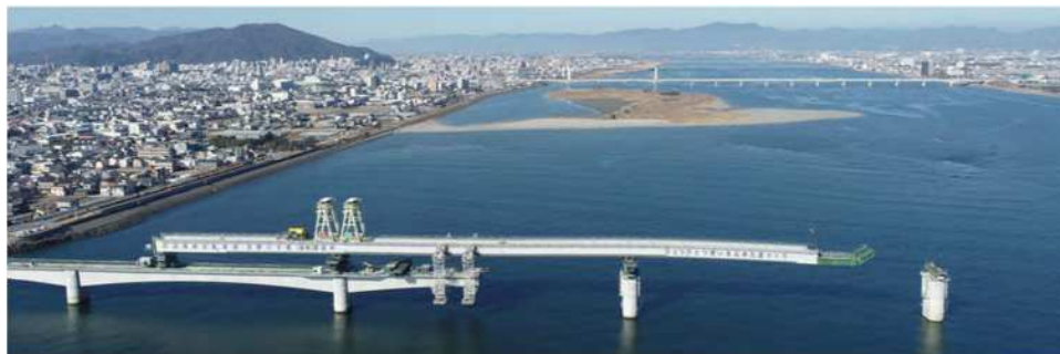
補助桁併用張出架設（国内最長級）
