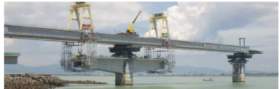
～支間長130mの鋼架設桁の送り出し～
