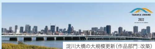
淀川大橋の大規模更新 (作品部門: 改築)
