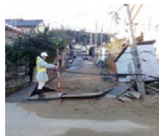
液状化により被災した道路の調査
