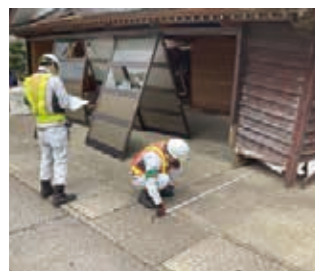
倒壊した家屋の調査
