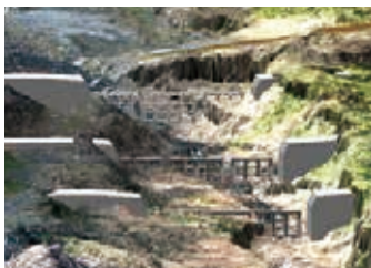
現場写真(3D)とCIMデータの合成(堰堤)
