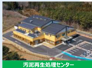
汚泥再生処理センター
